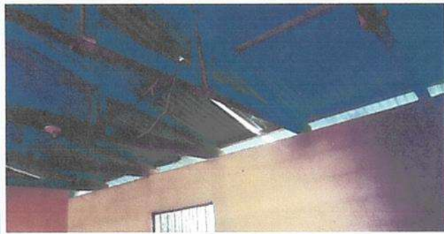
Foto 7: Reparación de sistema eléctrico (ducto eléctrico, accesorios focos ahorradores, plafoneras, interruptores, tomacorrientes)
