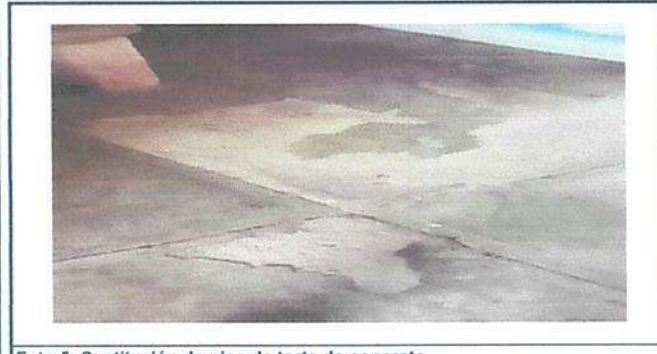
Foto 5: Sustitución de piso de torta de concreto
