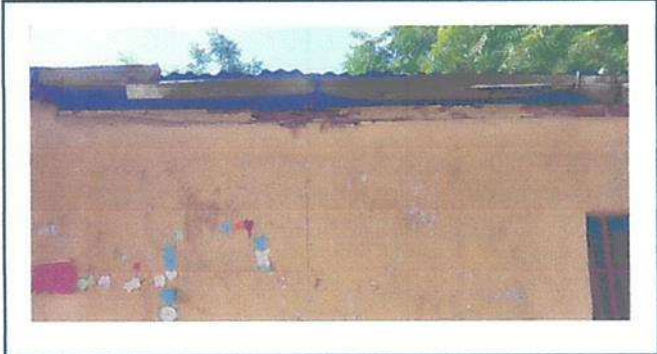
Foto 2: Sustitución de canal de metal
