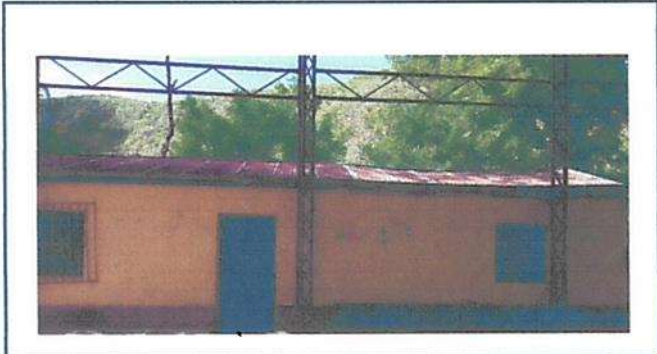
Foto1: Sustitución de lámina por lámina troquelada aluzinc callbre 26
